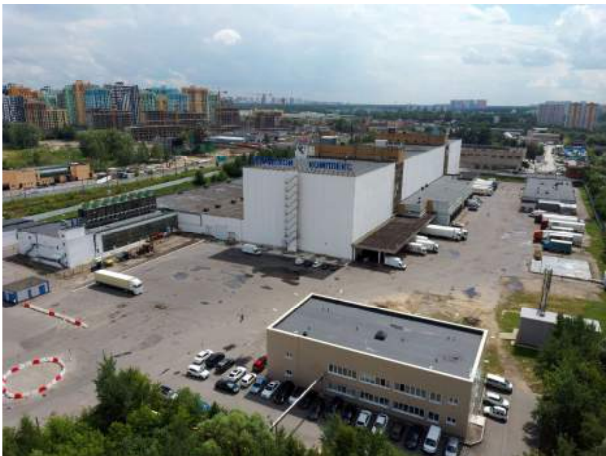
Общий вид строения №1
