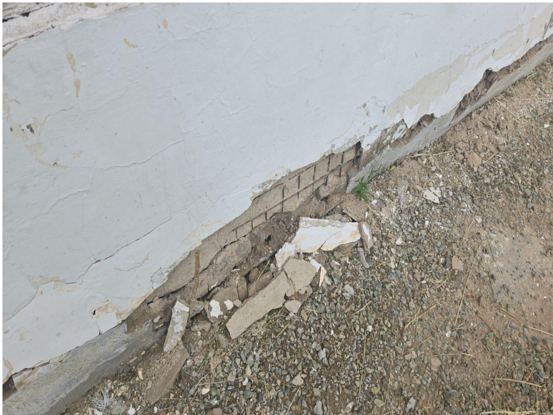
Рисунок 9-10. Состояние фундамента и отмостки
