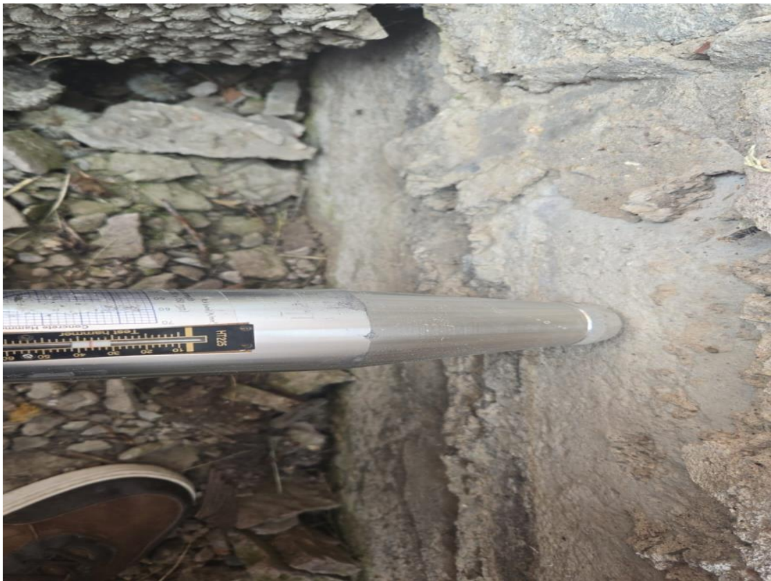
Рисунок 17. Измерение прочности бетона молотком Шмидта ударно-импульсным методом
