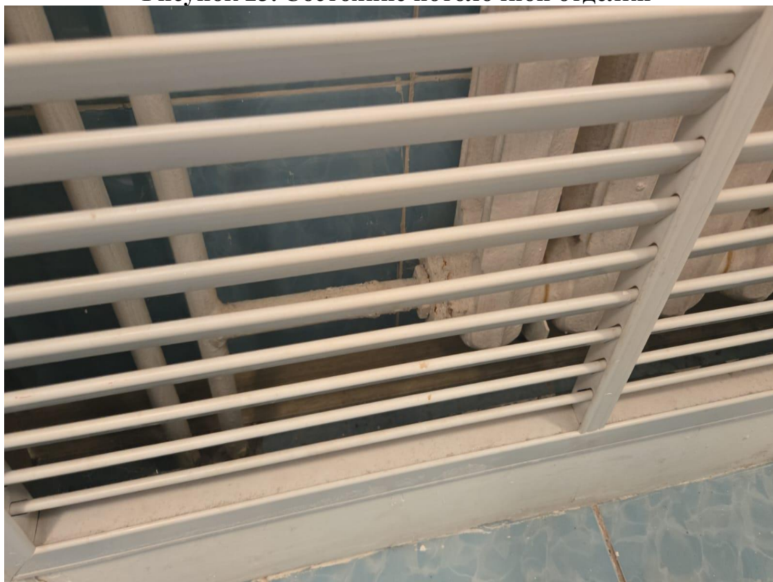
Рисунок 24. Состояние системы отопления
