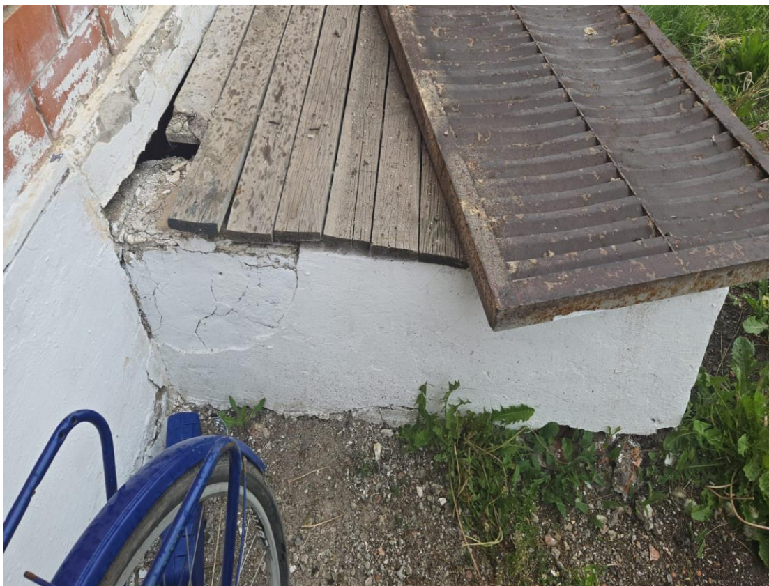
Рисунок 11-12. Состояние фундамента и отмостки
