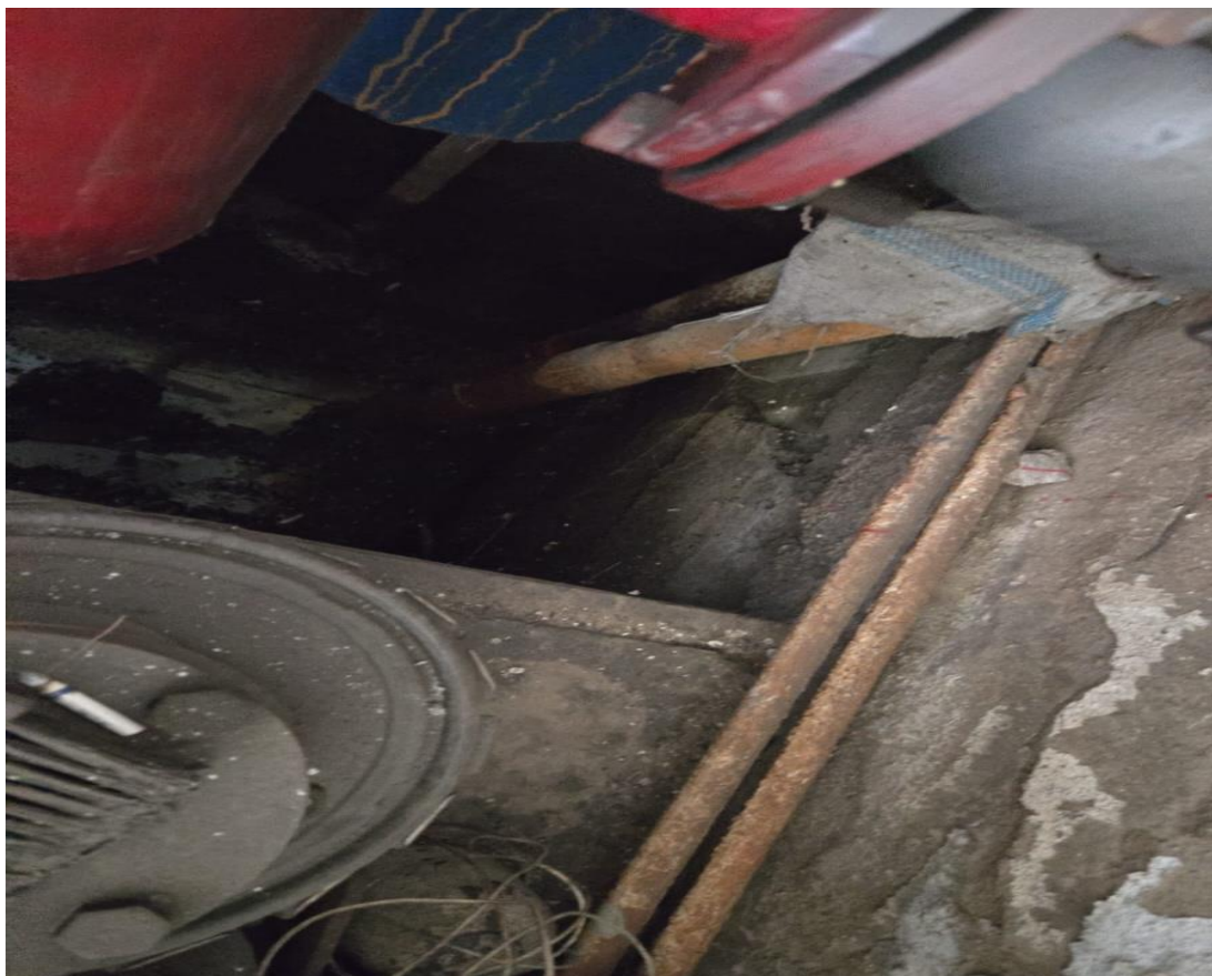
Рисунок 45. Состояние инженерных сетей
