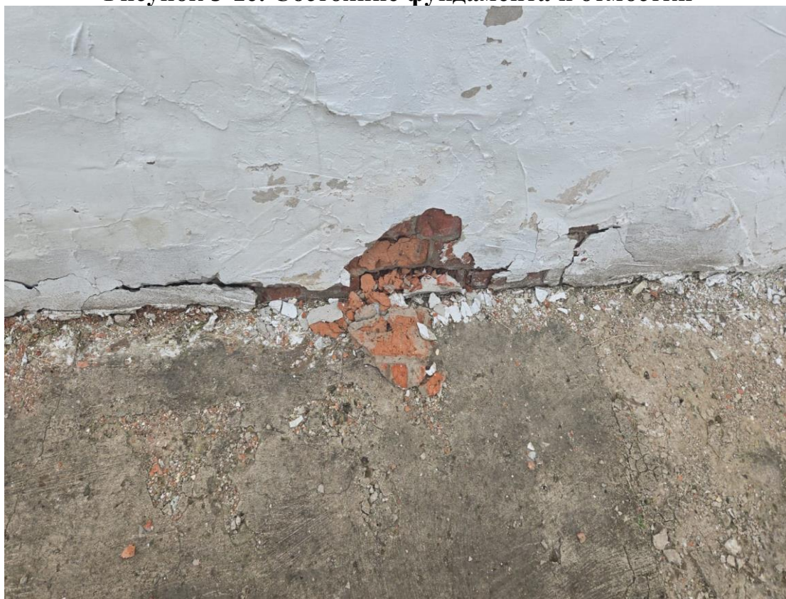
Рисунок 9-10. Состояние фундамента и отмостки
