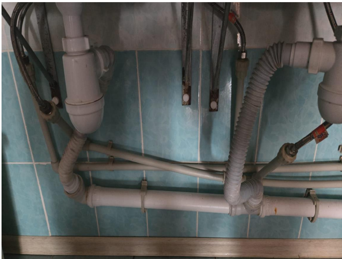
Рисунок 37. Состояние инженерного оборудования
