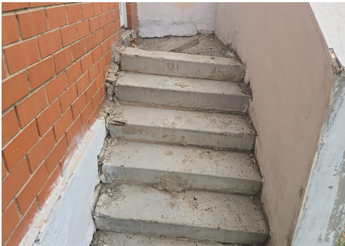
Рисунок 43-44. Состояние лестничного марша
