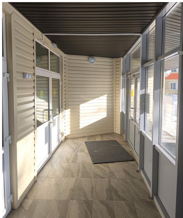
Фото №62. Тамбур у центрального входа.
