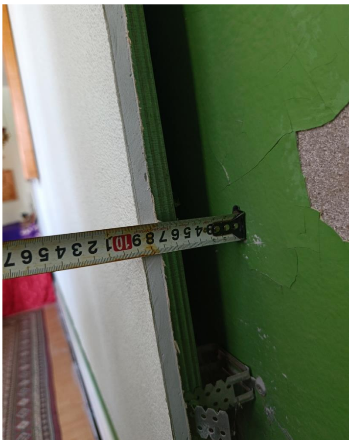
Фото 18. Толщина обшивки стен из листов ГКЛ по мет. каркасу 90 мм.
