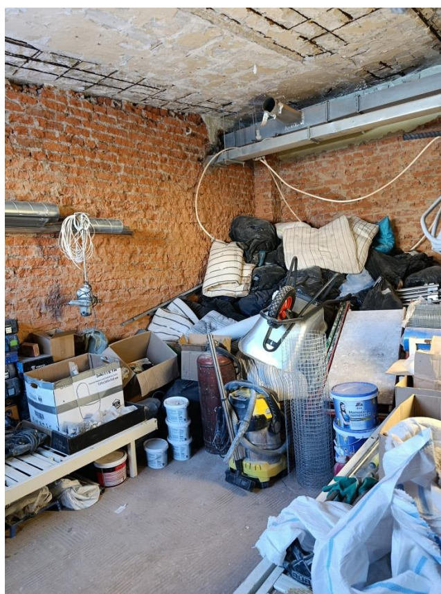
Фото 10. Фрагмент помещения в изоляторе.
