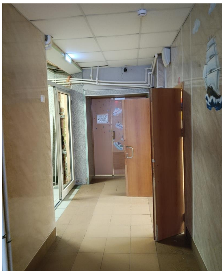
Фото 26. Фрагмент коридора в уровне 1-го этажа.
