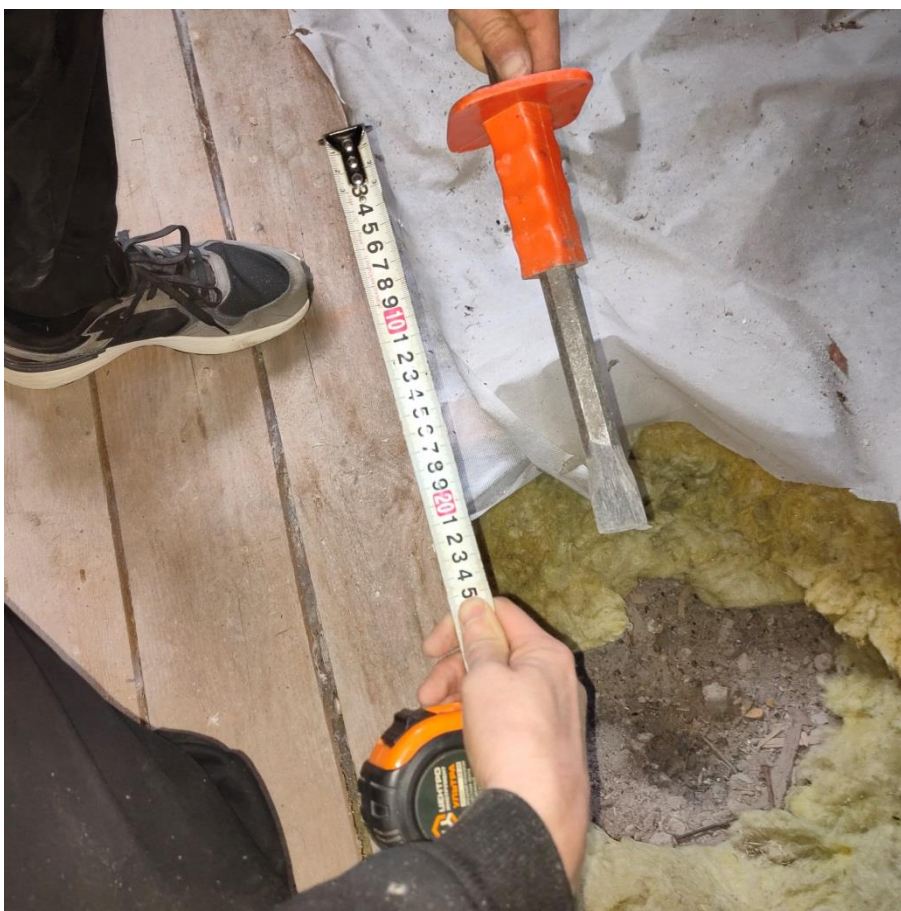
Фото 38. Вскрытие чердачного перекрытия.
