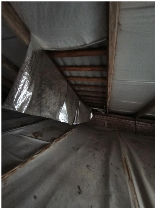
Фото 35. Фрагмент обрешетки из бруса 50х50 мм с шагом 350 мм.
