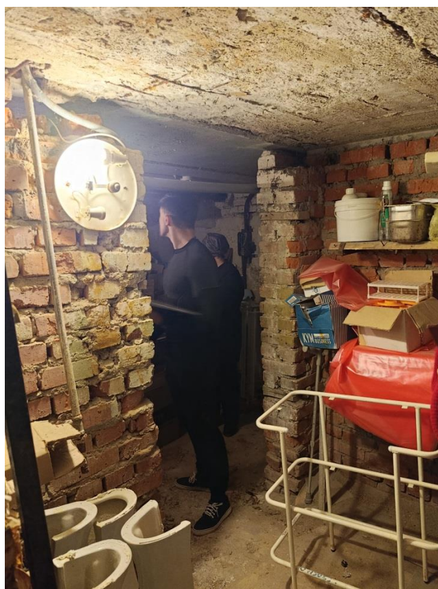
Фото 4. Фрагмент помещения подвала в осях 11-12/И.
