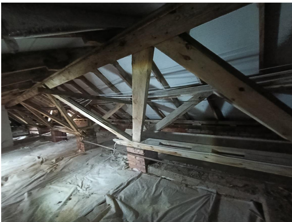
Фото 34. Общий вид чердака в обследуемой части здания.
