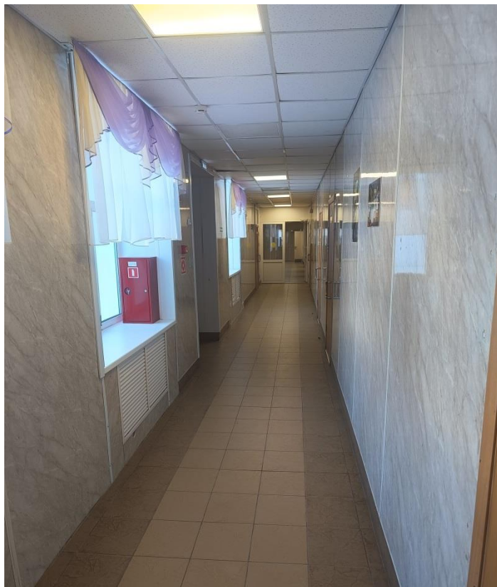
Фото №61. Защитные экраны отопления в коридоре
