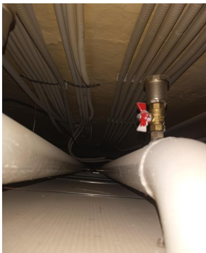
Фото №54. Запотолочное пространство в центральном коридоре
