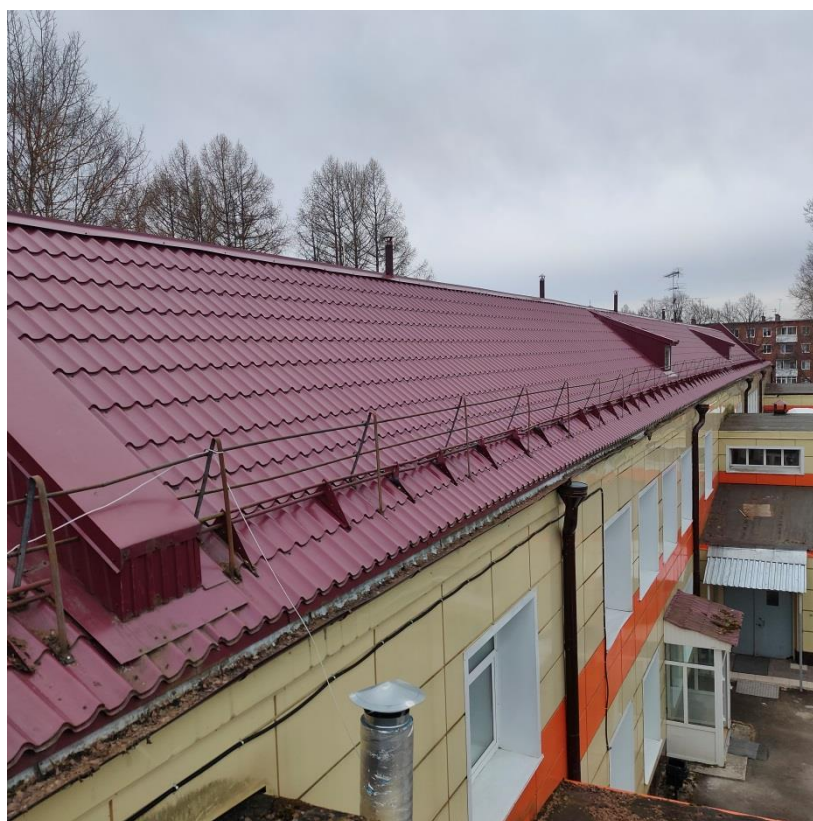
Фото 44. Общий вид карниза свеса кровли.
