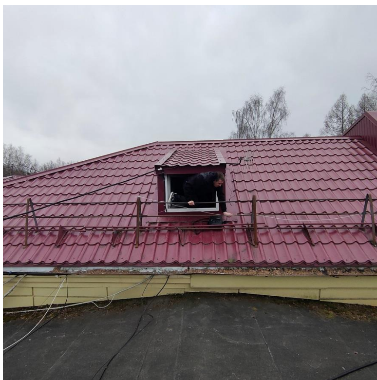
Фото 40. Общий вид слухового окна для выхода на плоскую кровлю спортзала.
