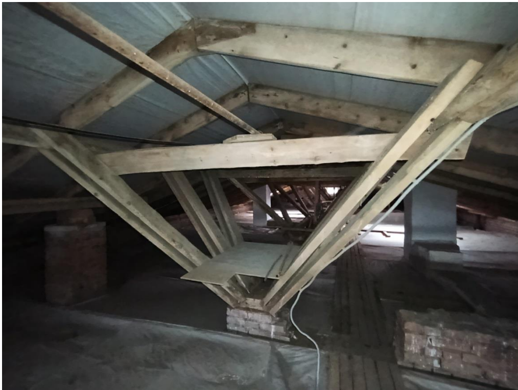
Фото 33. Фрагмент стропильных конструкций в обследуемой части здания.
