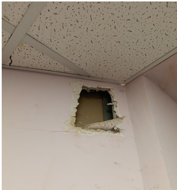
Фото 25. Вскрытие гипсокартонной перегородки.
