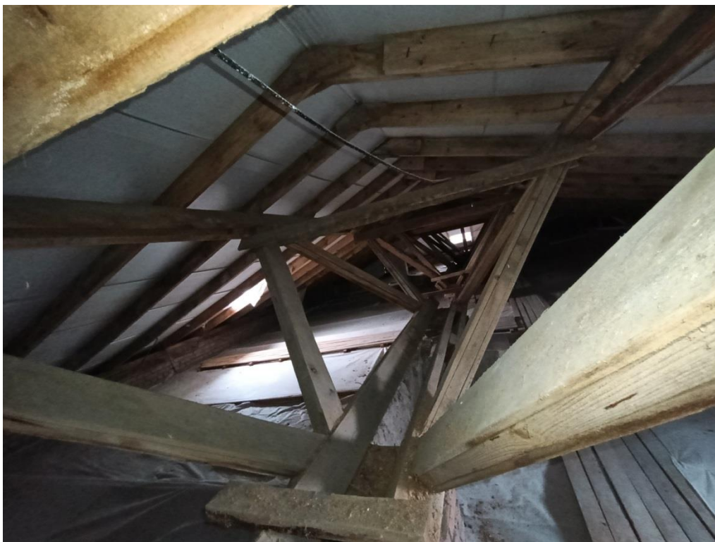
Фото 37. Фрагмент подстропильных конструкций в обследуемой части здания.
