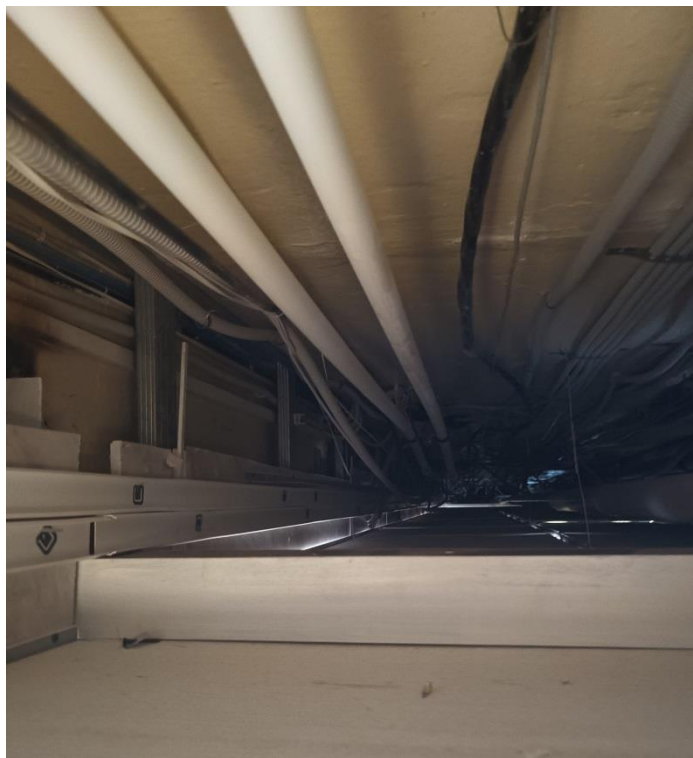
Фото №55. Запотолочное пространство в центральном коридоре
