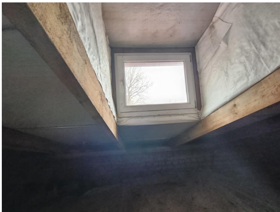
Фото 36. Общий вид слухового окна.
