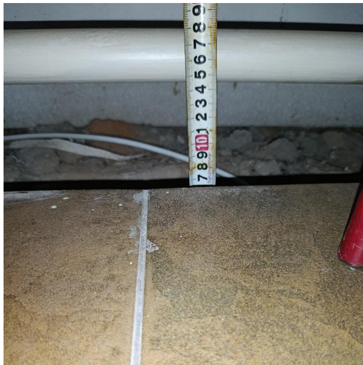
Фото 19. Толщина отделки пола 1-го этажа из керамической плитки 65 мм.
