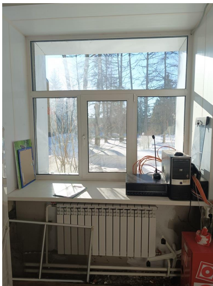
Фото №50. Подключение радиаторов в административном корпусе
