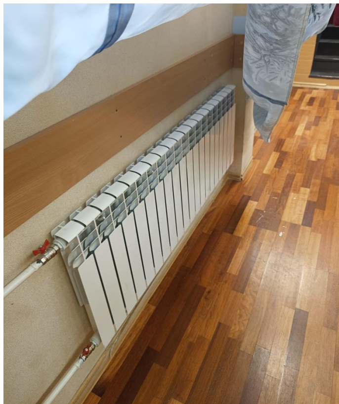
Фото №63. Подключение радиаторов.
